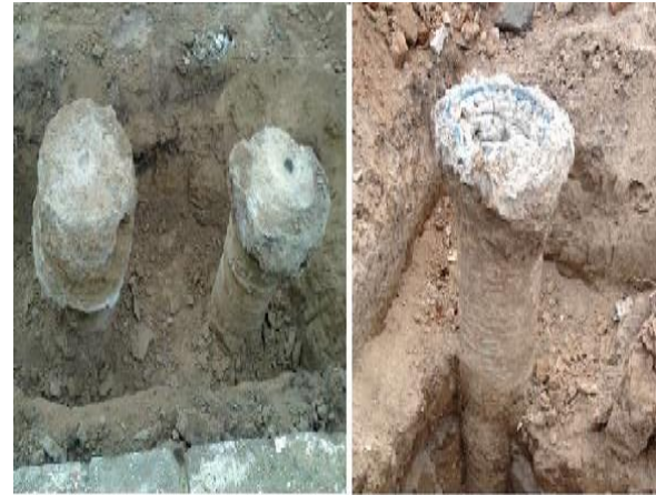
Şekil 11. DSM uygulaması kontrolü-1
